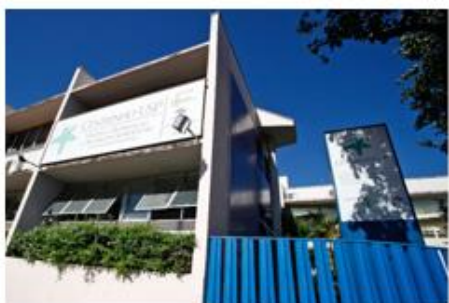
Detalhe para a fachada (área externa) da Unidade I do HRAC – Hospital de Reabilitação de Anomalias Craniofaciais (Centrinho) em Bauru – SP. Foto: Adauto Nascimento / Banco de Imagens do HRAC
