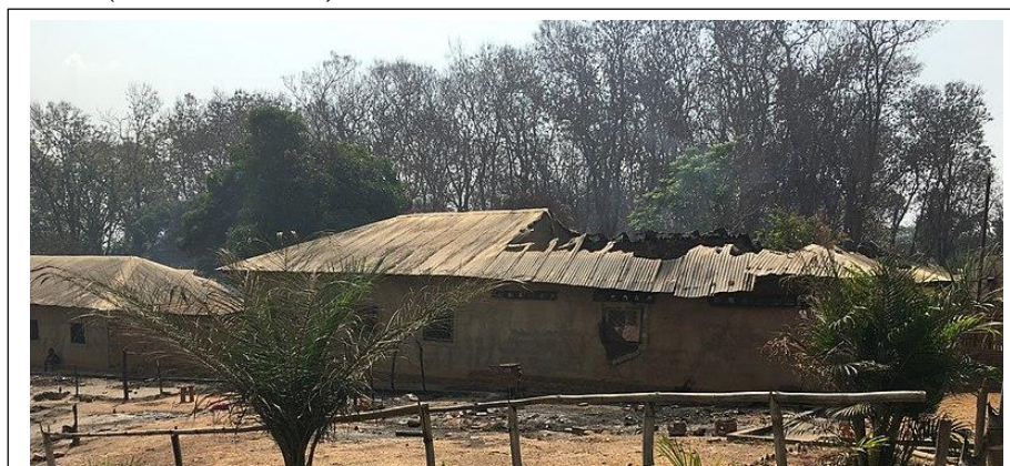
Casa queimada após ataque em Alindao. Nov. 2018. Autor: VOA. https://commons.wikimedia.org/wiki/File:Burned_house_in_Alindao,_Central_African_Republic,_29_November_2018.jpg
