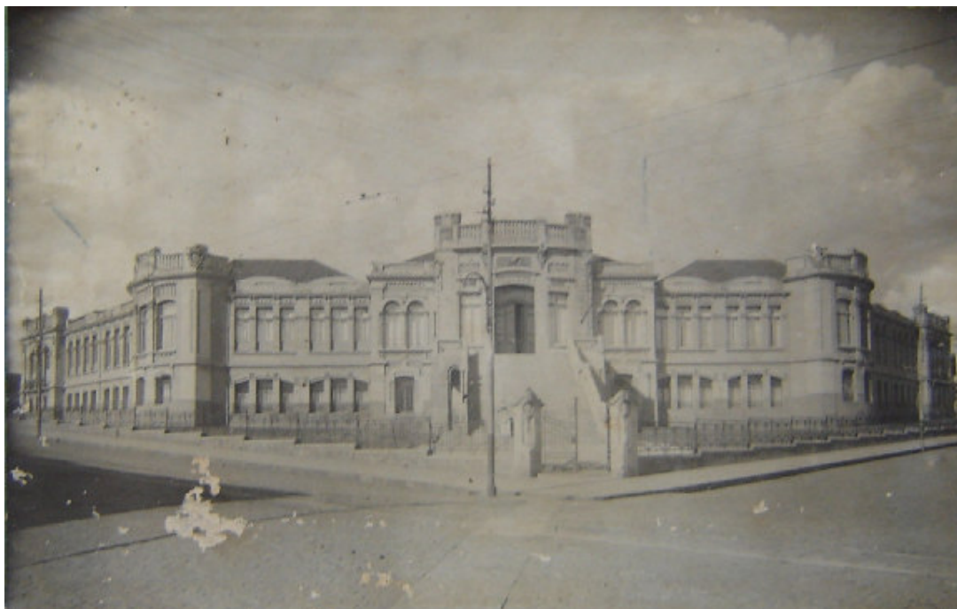
Ilustração 2: Prédio da Escola Normal Secundária de São Carlos na rua São Carlos, inaugurado em agosto de 1916
